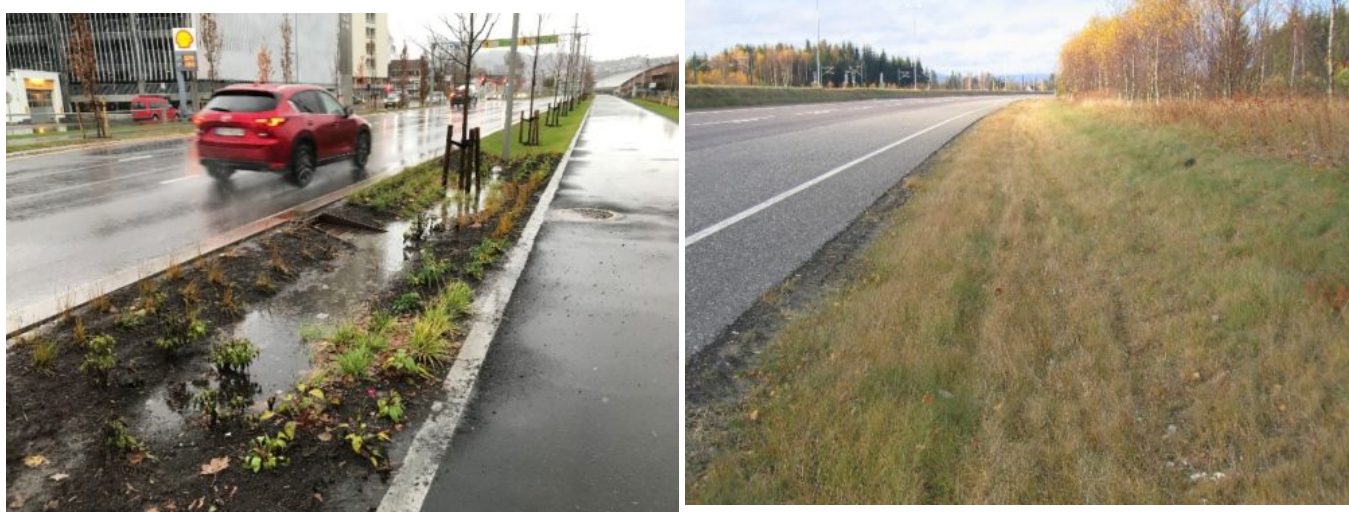
Figur 6: Eksempel på nedsenket grøntrabatt (filtergrøft) i bygate med avrenning fra kjørebane gjennom kantstein til filtersonen (venstre). Gaten har ingen sluk/sandfang i kjørebane (foto: Kirstine Laukli, SVV). Til høyre filtergrøft langs motorveg (foto: Svein Ole Åstebøl, COWI AS).
